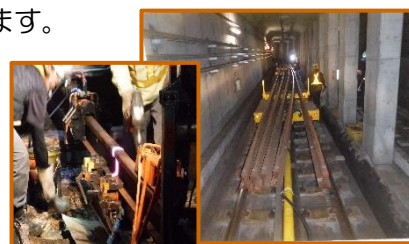
レール溶接・レール運搬作業
