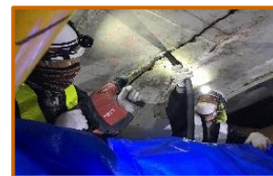
導水補修（止水）工事
